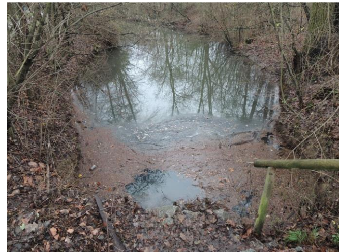
Bild 04: Verbindungskanal Altarm 9 zu Altarm 8, Einlauf: nach 20min Räumung
