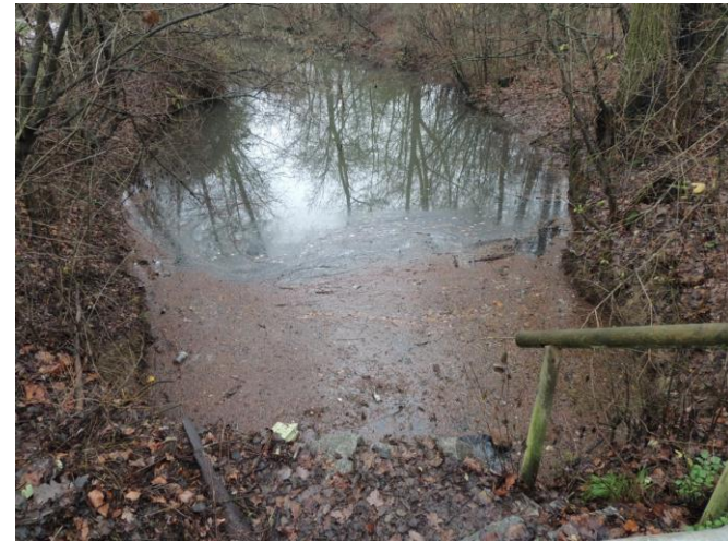
Bild 03: Verbindungskanal Altarm 9 zu Altarm 8, Einlauf: verlandet.
